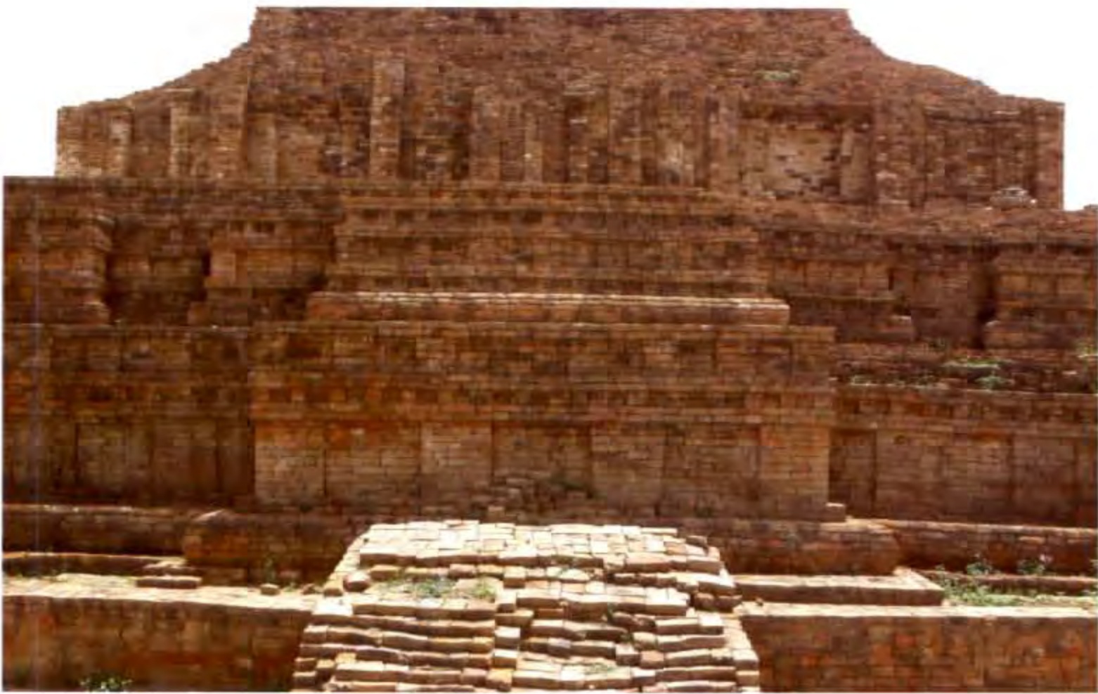
ภาพที่ ๓ บันได ส่วนล่าง และ ส่วนกลาง ซึ่งมีจรณะเรียงราย เหนือขึ้นไปคือส่วนที่ชำรุดทลายหลังการบูรณะแล้ว บนสุดคือระเบียงและเจดีย์ทรงปราสาท (ฐานชั้นที่ ๒ บังฐานชั้นที่ ๓ ซึ่งไม่เห็นในภาพนี้)
