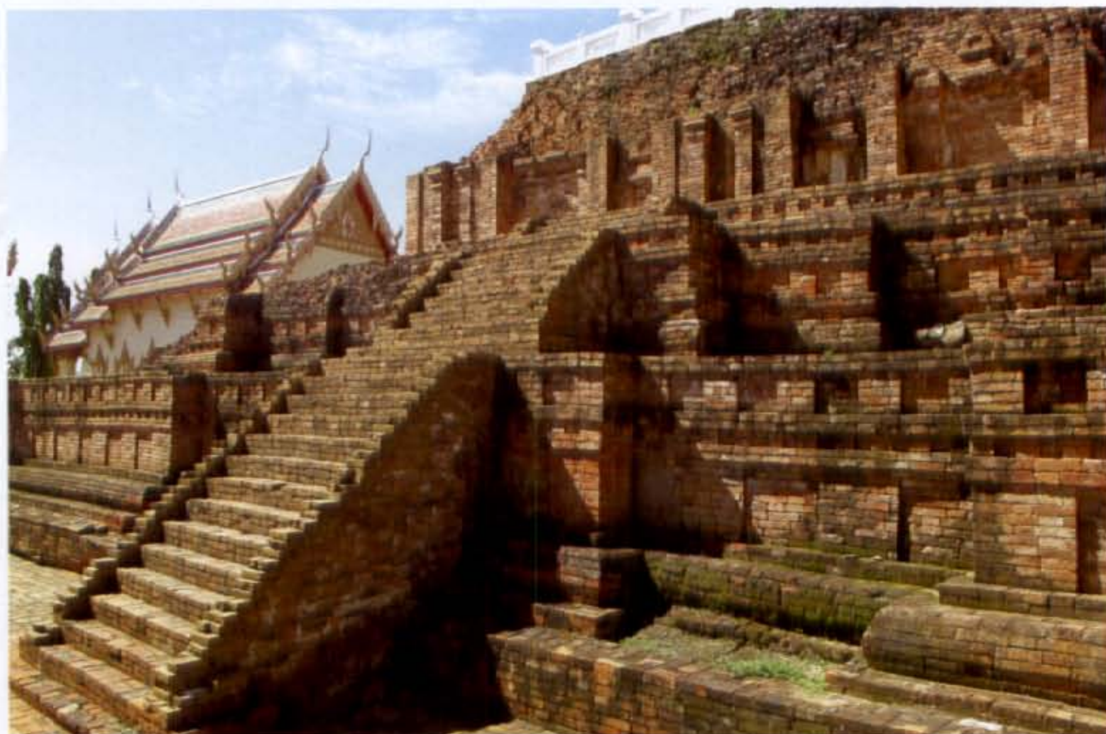
ภาพที่ ๒ ส่วนล่าง คือชั้นเชิงสี่เหลี่ยมด้านเท่า รองรับฐานยกเก็จที่ซ้อนลดหลั่น ๓ ฐาน (ฐานชั้นที่ ๒ บังฐานชั้นที่ ๓ ซึ่งไม่เห็นในภาพนี้)
