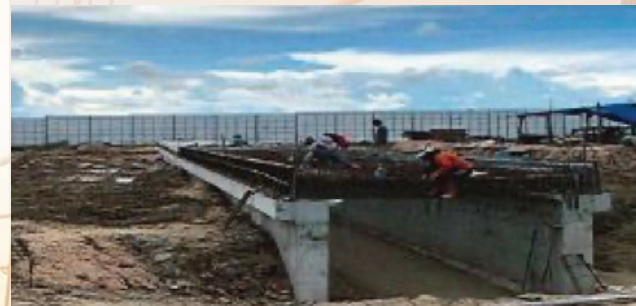
ภาพงานวัสดุถมใต้รองพื้นที่ทางพื้นที่ Taxi way
