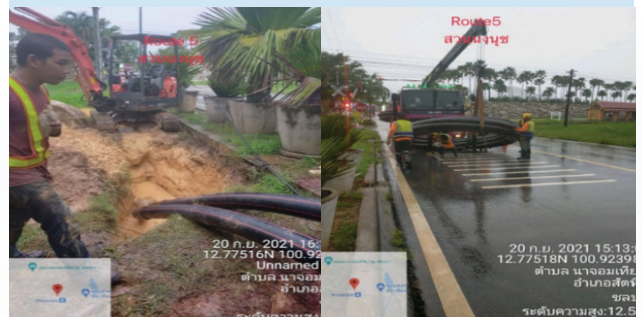
ภาพการเดินท่อร้อยสายไฟฟ้าใต้ดิน บริเวณสวนนงนุช
