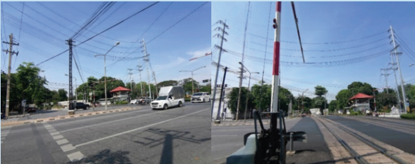
ภาพก่อสร้างเสาไฟฟ้ายกระดับ บริเวณช่วงพญาไท - ดอนเมือง (แยกศรีอยุธยา)
