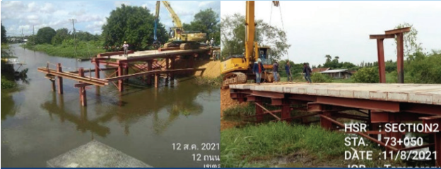
ภาพงานติดตั้งสะพานชั่วคราว เพื่อลำเลียงวัสดุก่อสร้าง
