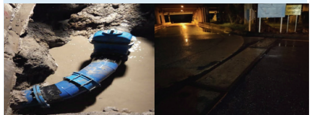
ภาพการรื้อย้ายท่อน้ำประปาใต้ดิน บริเวณมอเตอร์เวย์ 7
