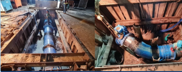
ภาพการร้อยย้ายท่อน้ำประปาใต้ดิน บริเวณสถานีรถไฟแอร์พอร์ต เรลลิงก์
