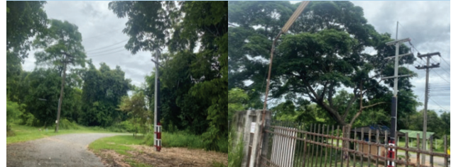
ภาพการเดินท่อร้อยสายไฟฟ้าใต้ดิน บริเวณค่ายลูกเสือชiras
