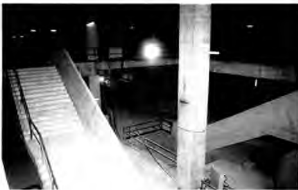
การก่อสร้างสถานีรถไฟฟ้าใต้ดิน โครงการรถไฟฟ้าฟ้ามหานคร สายเฉลิมรัชมงคล
