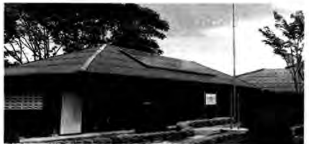
โครงการเฉลิมพระเกียรติ ระบบผลิต และจำหน่ายไฟฟ้าจากเซลล์แสงอาทิตย์ บนหลังคาอาคารศูนย์พัฒนา อันเนื่องมาจากพระราชดำริ ห้วยทราย จังหวัดเพชรบุรี
