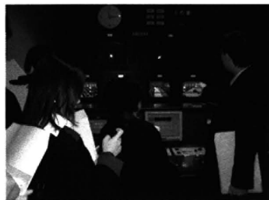
ห้องควบคุมการบันทึกโทรทัศน์วงจรปิด
