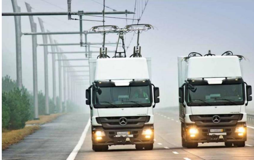
ภาพที่ ๒๘ ระบบติดตั้งสายไฟฟ้าบนถนน (electric road systems)
