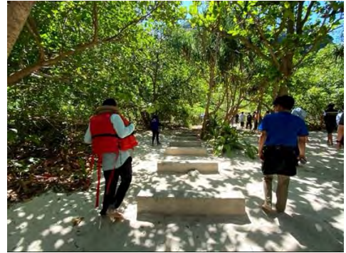
เส้นทางเดิน (Boardwalk) ส่วนที่ยังสร้างไม่เสร็จ
