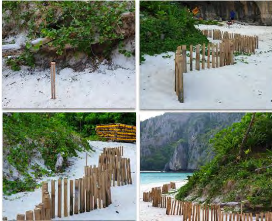
ภาพที่ ๑๓ การทดลองติดตั้งรั้วไม้เพื่อฟื้นฟูสนทรายชายหาด (กรมอุทยานแห่งชาติ สัตว์ป่า และพันธุ์พืช)
