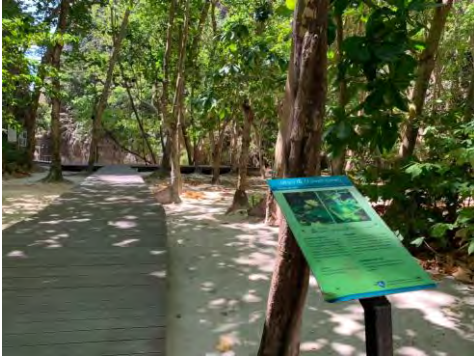
เส้นทางเดิน (Boardwalk) ส่วนที่สร้างเสร็จแล้ว
