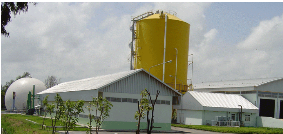
ภาพที่ 2.64 โรงผลิตปุ๋ยอินทรีย์และพลังงาน เทศบาลนครระยอง
