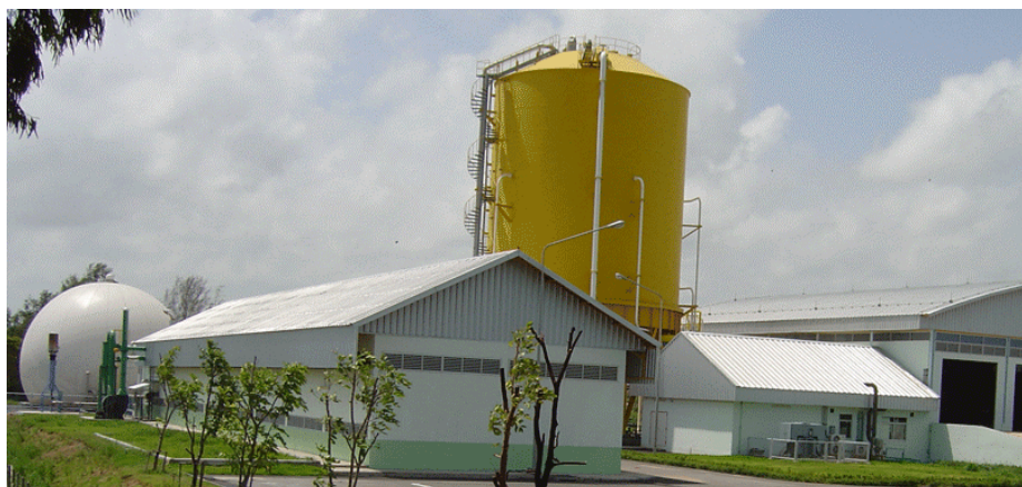
ภาพที่ 4.6 ระบบระบบย่อยสลายแบบไม่ใช้ออกซิเจนเทศบาลนครระยอง รองรับขยะอินทรีย์ได้ 60 ตัน/วัน ออกแบบให้ผลิตกระแสไฟฟ้าได้ 0.625 MW
