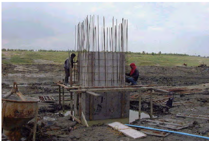
ภาพที่ 2.81 ก่อสร้างบ่อรวบรวมน้ำเสีย
