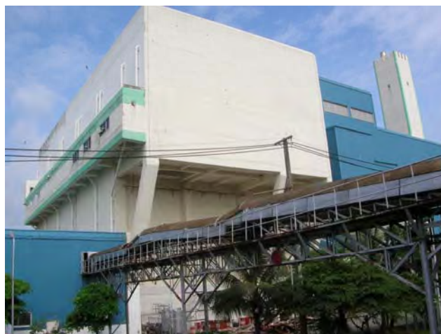
ภาพที่ 4.1 เตาเผาขยะชุมชน จังหวัดภูเก็ตขนาดรองรับปริมาณขยะชุมชน 250 ตัน/วัน ออกแบบให้ผลิตกระแสไฟฟ้าได้ประมาณ 2.5 MW
