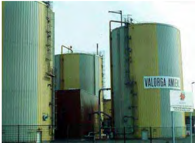
ภาพที่ 2.11 ระบบย่อยสลายแบบไม่ใช้ออกซิเจน VALORGA Process ในประเทศฝรั่งเศส ที่มา: http://www.biogaswork.com
