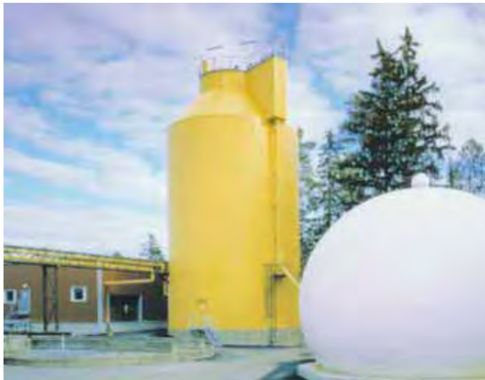
ภาพที่ 2.16 ระบบย่อยสลายแบบไม่ใช้ออกซิเจน WABIO Process ที่เมือง Forssa ฟินแลนด์ ที่มา: Skanska Econet OY (2000)
