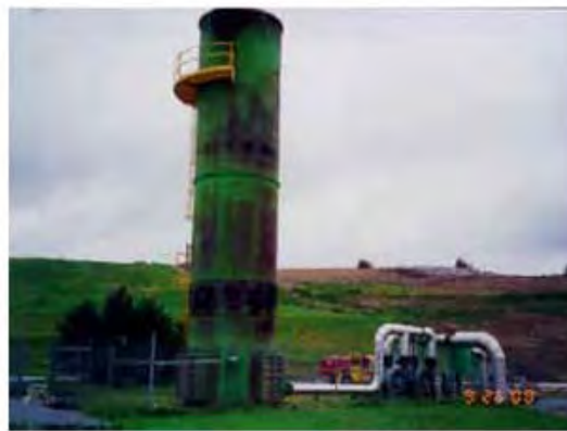
ภาพที่ 2.32 ลักษณะการติดตั้ง Final Blower/Flare Station แบบ Enclosed Flaring System
