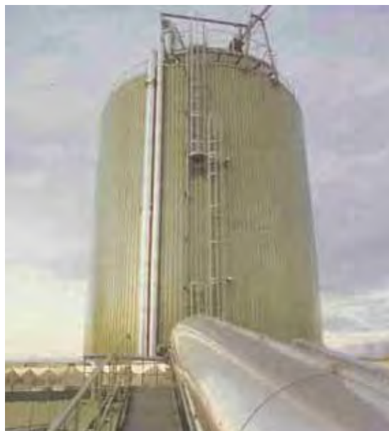
ภาพที่ 2.10 ระบบย่อยสลายแบบไม่ใช้ออกซิเจน DRANCO Process ที่เมือง Salburg ออสเตรีย ที่มา: Organic Waste system, N.V.
