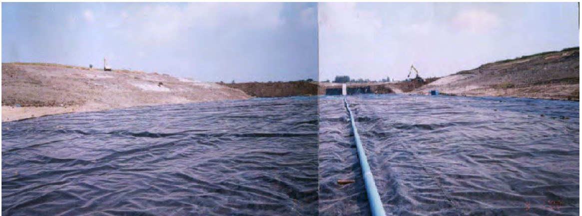
ภาพที่ 2.80 การปูแผ่น HDPE ด้านล่าง-ด้านข้าง และเดินท่อรวบรวมน้ำชะขยะ
