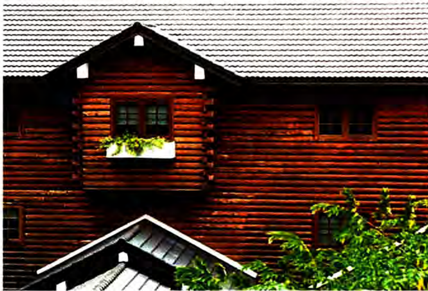
ภาพที่ 6 ลักษณะของการใช้ผนังไม้เป็นผนังภายนอกอาคาร ซึ่งมีความสวยงามและกลมกลืนกับสภาพแวดล้อม ไม้เป็นวัสดุที่มีความเป็นฉนวนกันความร้อนได้ในระดับหนึ่ง แต่มีค่าการดูดซับความชื้นค่อนข้างสูง
