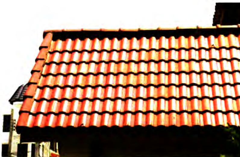
ภาพที่ 2 ลักษณะของหลังคากระเบื้องคอนกรีตหรือกระเบื้องซีแพคโมเนีย ซึ่งเป็นวัสดุที่นิยมใช้มากในปัจจุบัน มีความแข็งแรงทนทาน และมีลวดลายสีสันท่างๆ ให้เลือกใช้ได้ตามความต้องการ แต่มีข้อเสียคือ มวลสารมากทำให้มีการดูดกลืนความร้อนสูง จึงควรใช้ควบคู่กับการติดตั้งฉนวนกันความร้อน
