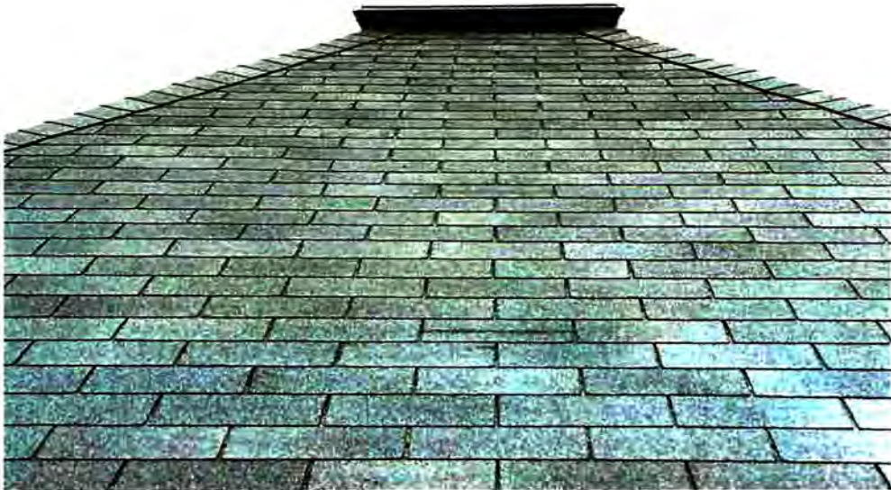
ภาพที่ 4 ลักษณะของหลังคาซิงเกิล ซึ่งเป็นวัสดุมวลสารต่ำ ไม่สะสมความร้อน ทนทานต่อสภาพอากาศและกันความชื้นได้เกือบ 100% การติดตั้งทำได้ง่าย มีความยืดหยุ่นสูง สามารถติดตั้งได้กับหลังคาทุกรูปแบบและทุกลักษณะ แต่มีค่าความต้านทานความร้อนไม่สูงมากนัก ควรติดตั้งร่วมกับฉนวน
