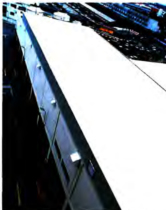
ภาพที่ 3 ลักษณะของหลังคาโลหะ ซึ่งมีความแข็งแรงทนทาน และสามารถป้องกันความชื้นได้เกือบ 100% แต่มีข้อเสียคือเกิดสนิมได้ง่าย ต้องป้องกันด้วยการทาหรือเคลือบผิวด้วยวัสดุกันสนิม นอกจากนั้นโลหะยังมีค่าการนำความร้อนสูงมาก จึงควรใช้งานร่วมกับฉนวนเพื่อลดความร้อนที่เข้าสู่อาคาร
