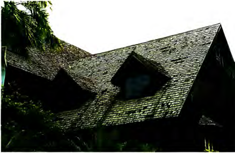
ภาพที่ 1 ตัวอย่างการใช้แป้นเกล็ดหรือกระเบื้องไม้ในส่วนหลังคาซึ่งมีความสวยงามกลมกลืนกับสภาพแวดล้อม วัสดุประเภทนี้ไม่มีความเป็นฉนวนกันความร้อนได้ในระดับหนึ่ง แต่มีข้อเสียคือหายากและมีค่าการดูดซับความร้อนสูง
