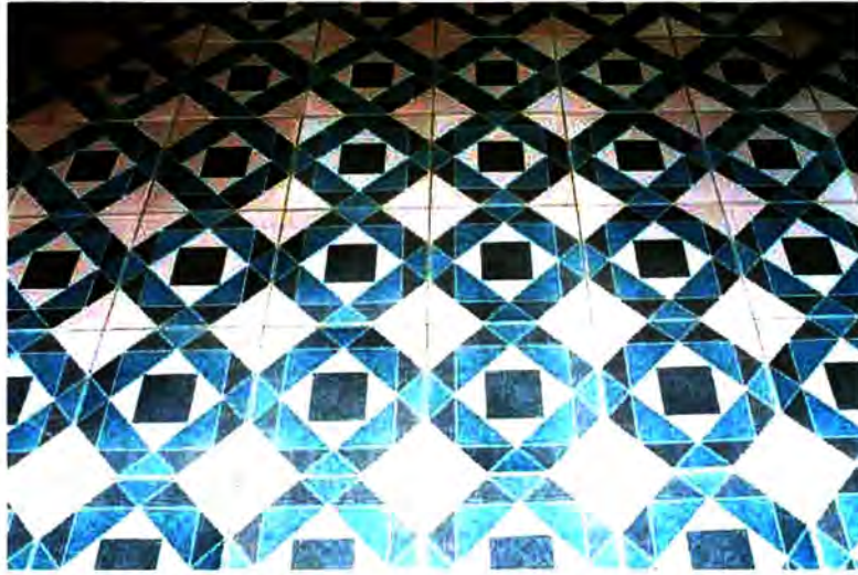
ภาพที่ 13 ลักษณะของวัสดุพื้นอาคารประเภทกระเบื้อง ซึ่งมีความคงทนแข็งแรง ทนทานต่อสารเคมี ดัดตั้งและดูแลรักษาง่าย มีความสวยงาม สามารถเลือกใช้ได้หลากหลายรูปแบบ โดยเฉพาะกระเบื้องเคลือบจะมีค่าการดูดกลืนความร้อนและดูดซับความชื้นต่ำ
