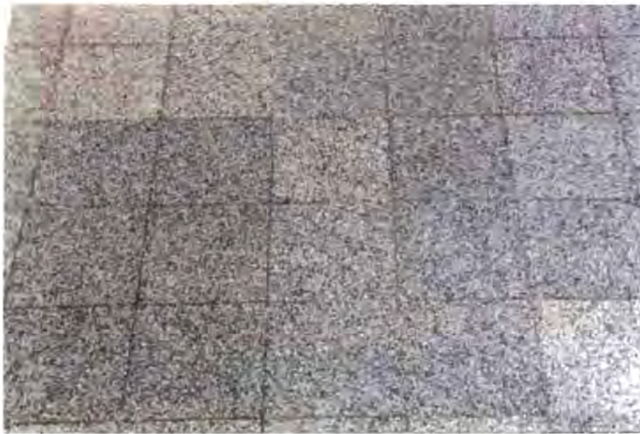
ภาพที่ 11 ลักษณะของวัสดุพื้นอาคารประเภทหิน ซึ่งมีความแข็งแรงทนทาน ทนต่อแรงกด และแรงกระแทกได้ดี สามารถนำมาใช้เพื่อช่วยดึงเอาความเย็นจากพื้นดินเข้ามา ภายในอาคาร
