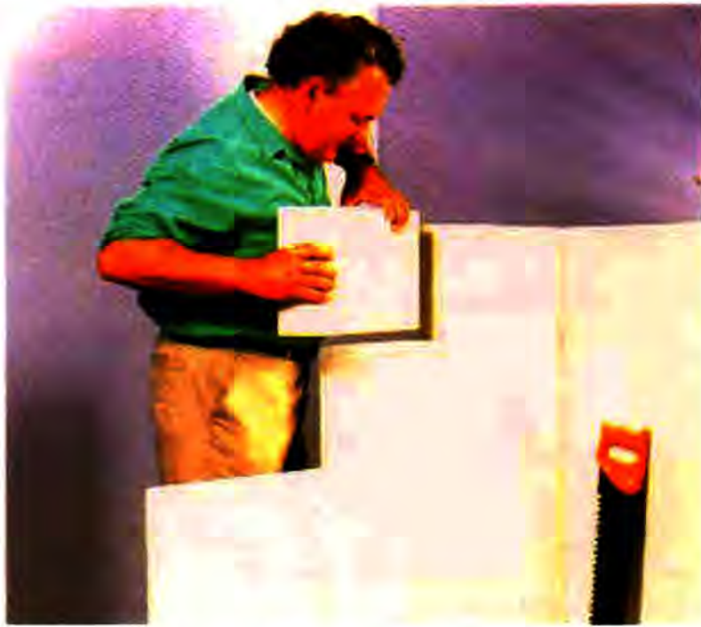
ภาพที่ 8 วิธีการก่อสร้างผนังอาคารด้วยคอนกรีตมวลเบา ซึ่งเป็นวัสดุที่มีน้ำหนักเบา มีความเป็นฉนวนกันความร้อนและกันเสียงได้ในระดับหนึ่ง
