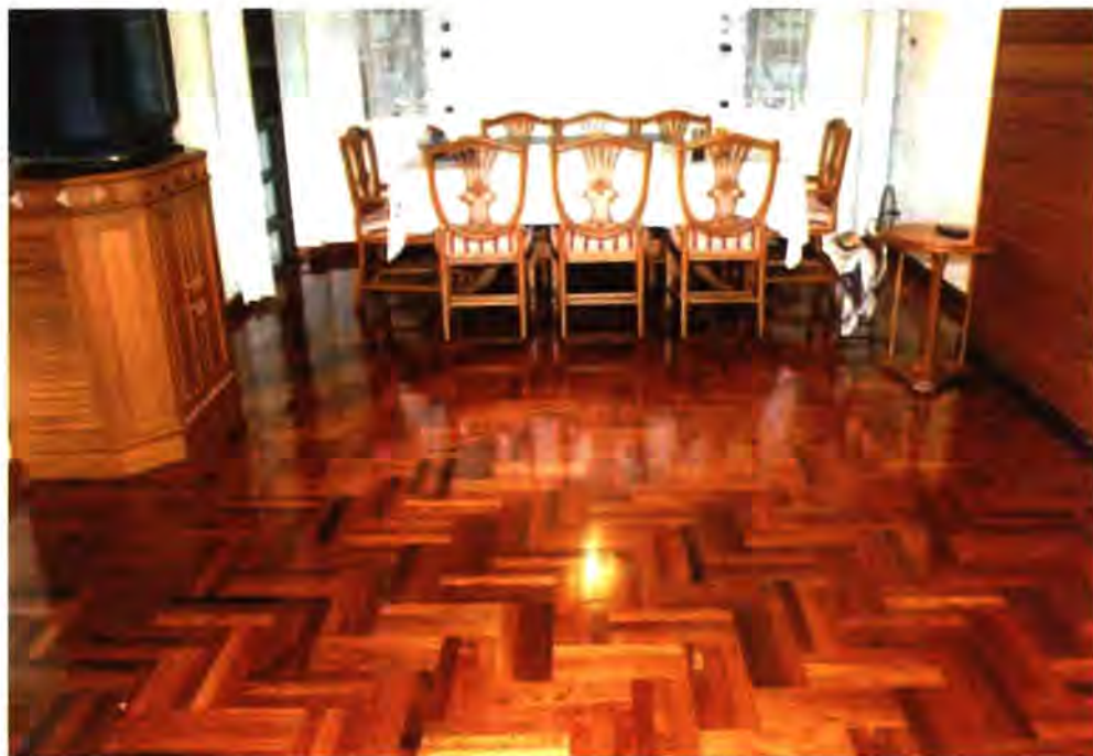
ภาพที่ 12 ลักษณะของวัสดุพื้นอาคารประเภทไม้โดยเฉพาะไม้เนื้อแข็งจะมีค่าการดูดกลืนความร้อนและดูดซับความชื้นสูง จึงควรปิดหรือเคลือบผิวไม้ด้วยวัสดุอื่นที่มีการป้องกันความร้อนและความชื้นที่ดีเมื่อใช้ในอาคารปรับอากาศ
