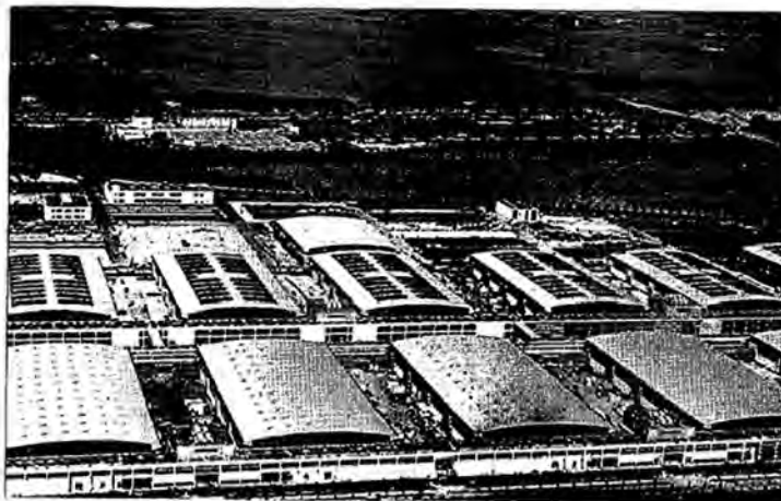
ทัศนียภาพศูนย์แสดงสินค้านานาชาติเมืองมิวนิค บนหลังคาจะสังเกตเห็นระบบเซลล์แสงอาทิตย์ จำนวน 7,812 แผง
