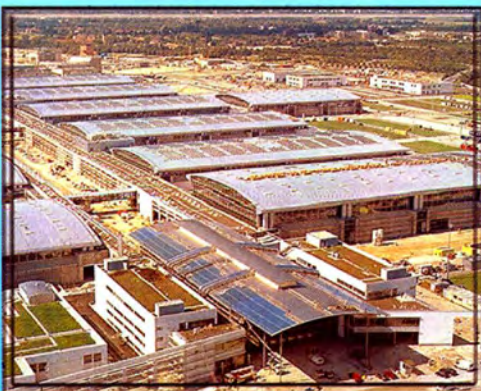
ภาพถ่ายทางอากาศจะเห็นระบบเซลล์แสงอาทิตย์ขนาด 1 เมกะวัตต์ บนหลังคาอาคารแสดงสินค้านานาชาติ เมืองมิวนิค ประเทศเยอรมนี
