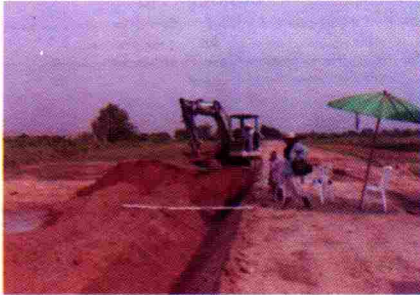
“ ภาพคูส่งน้ำ (กรมชลประทานดำเนินการขุดตามแนวที่เจ้าหน้าที่กรมที่ดินได้ให้แนวไว้) “
