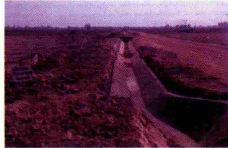
“ ภาพคูส่งน้ำ (กรมชลประทานดำเนินการขุดตามแนวที่เจ้าหน้าที่กรมที่ดินได้ให้แนวไว้) “
