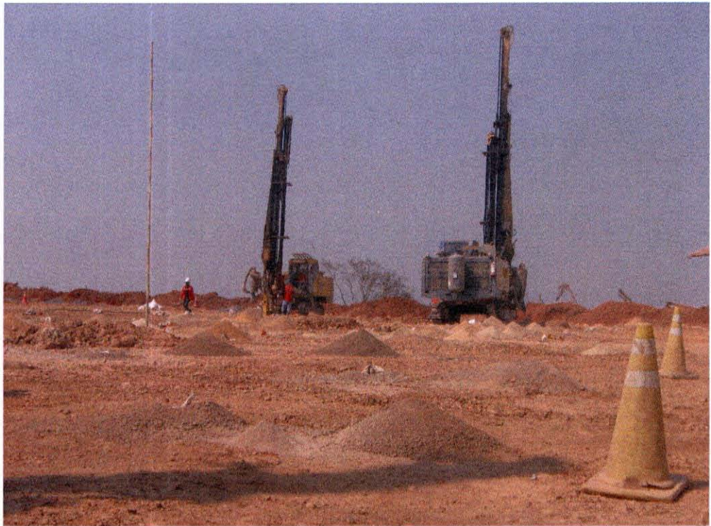
ขั้นตอนการเจาะระเบิดบนยอดเขาหม้อ
