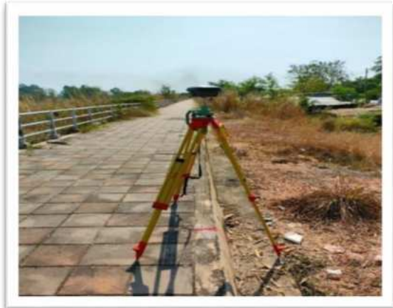
รูปที่ 6 - 17 ตัวอย่างการปฏิบัติงานภาคสนามในการสำรวจปักหลักหมุดแนวถนนโครงการ
