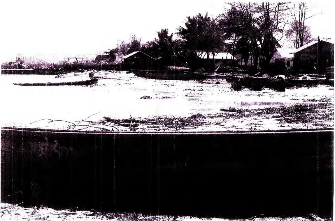
สภาพแหล่งน้ำและบ้านเรือนของประชาชนที่ได้รับความเสียหาย จากเหตุการณ์ธรณีพิบัติใน ๖ จังหวัดภาคใต้
