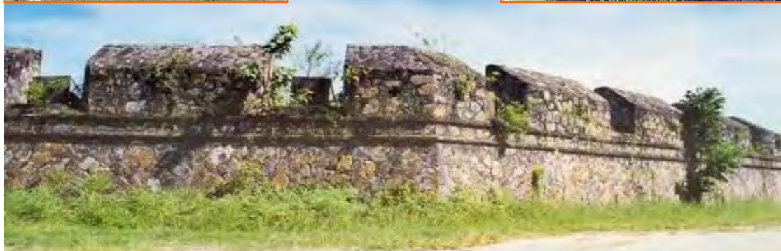
สภาพโดยทั่วไปของป้อมปืนปากน้ำแหลมทราย
