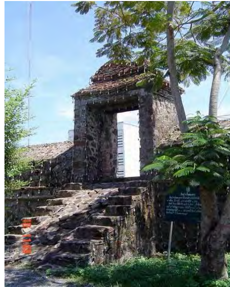
บันไดทางขึ้นป้อมปืนปากน้ำแหลมทราย
