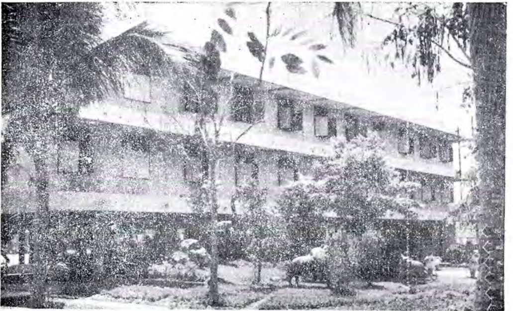
อาคารทอนอนชาย ชั้นล่างใช้เป็นห้องประชุม
