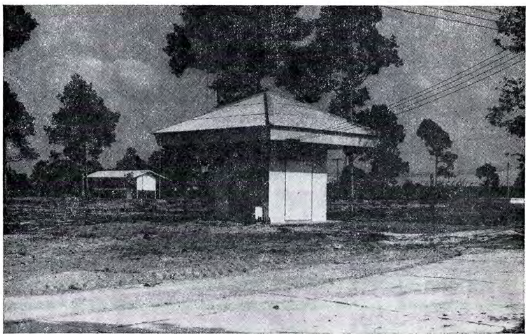
โรงสูบน้ำบาดาล
