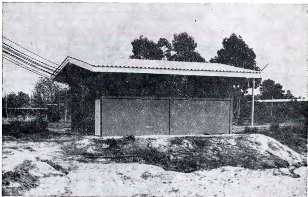
อาคารไฟฟ้า
