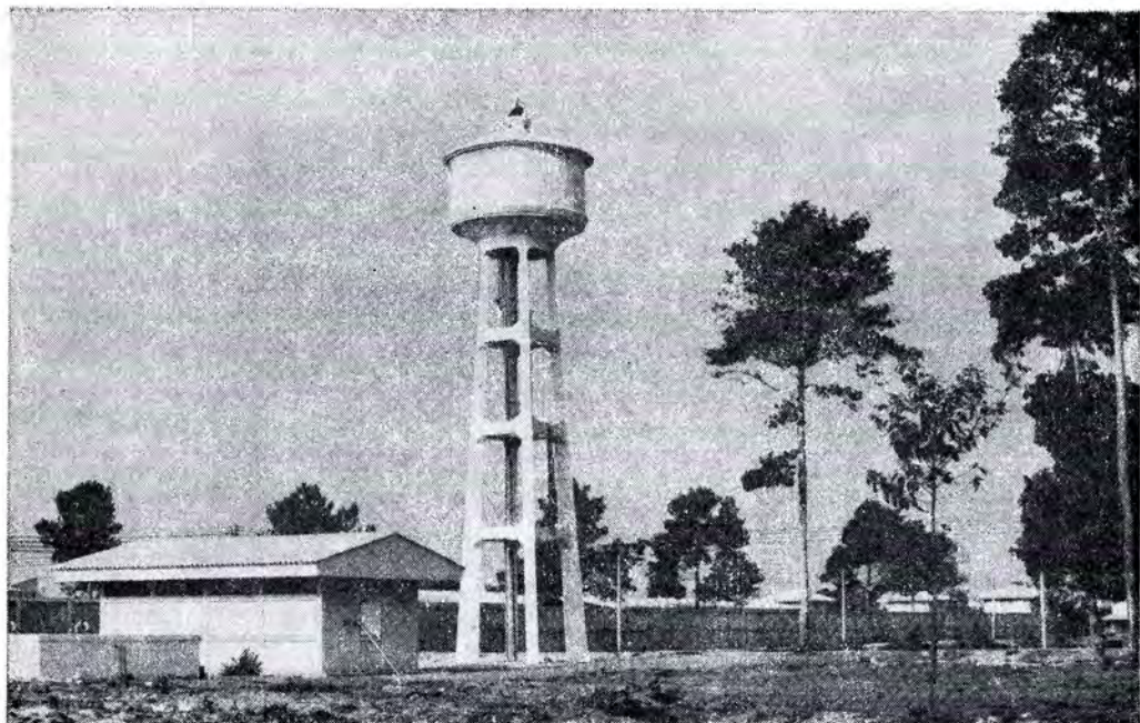
ถังน้ำใส โรงสูบน้ำและจ่ายสารเคมี และหอถังสูง
