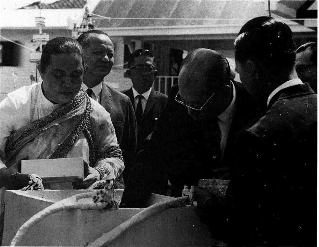
พิธีวางศิลาฤกษ์ การก่อสร้างอาคาร สำนักงานสรวงศ์ วันที่ 15 สิงหาคม 2510
