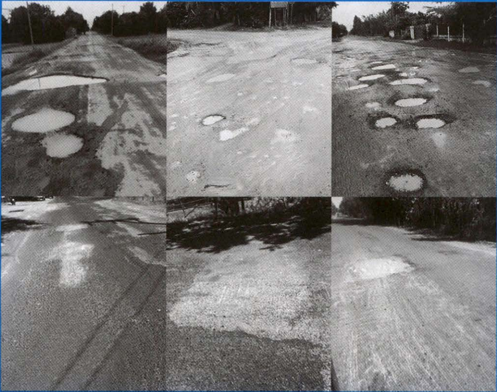
ภาพถ่ายสภาพถนน ก่อน และหลังซ่อมแซม
