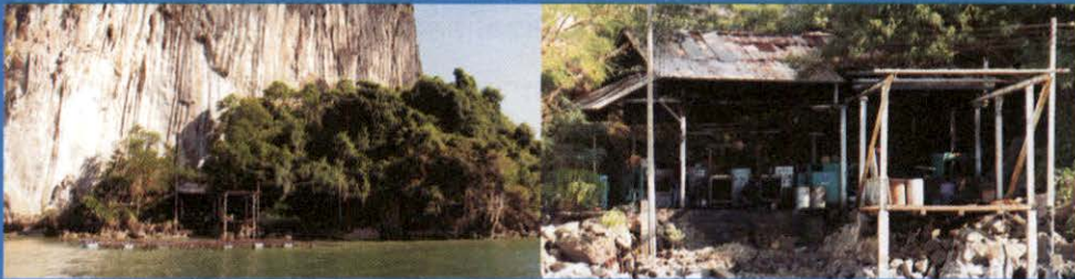
โรงจักรไฟฟ้าติเซลบนเกาะ
