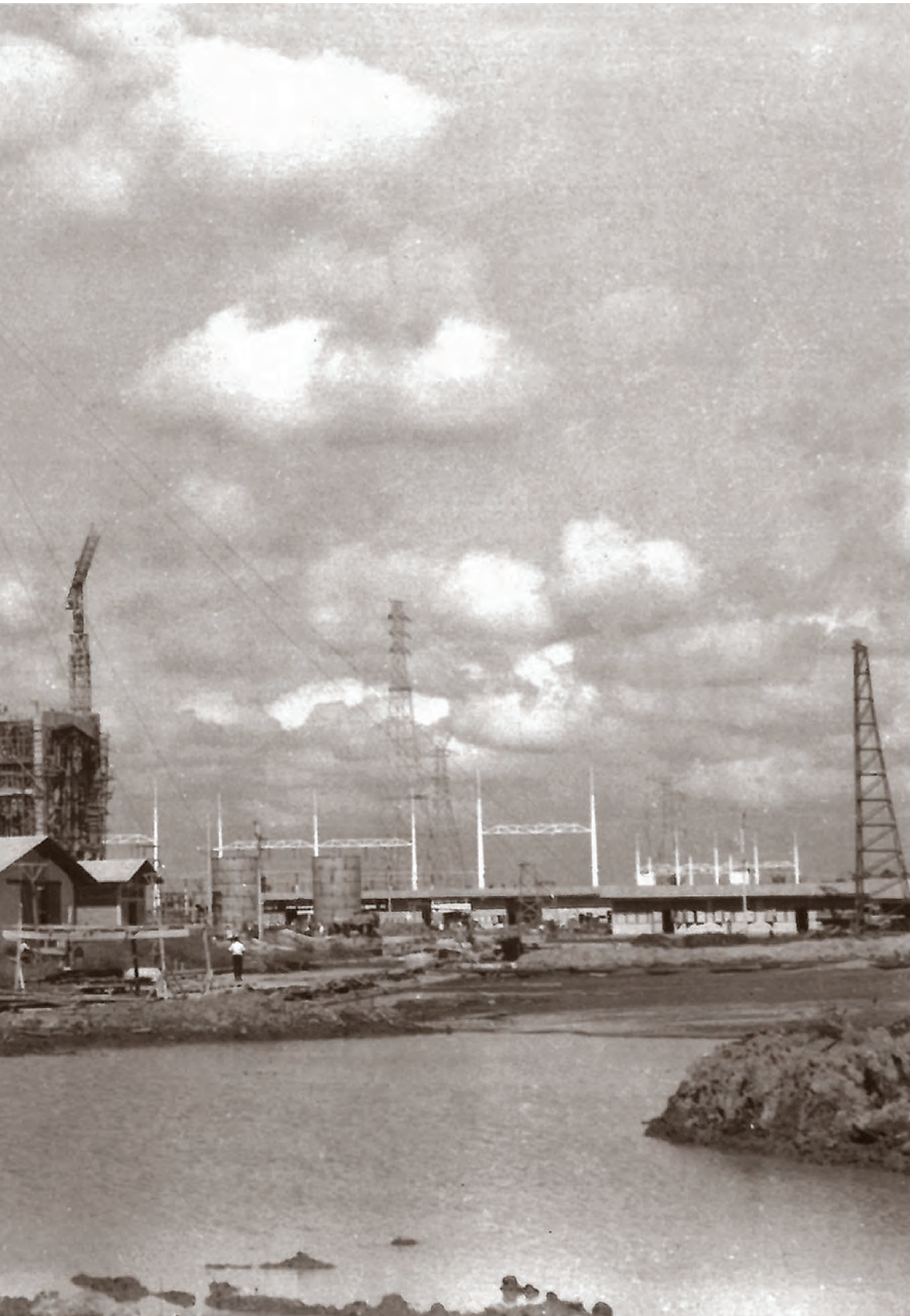
โรงไฟฟ้าพระนครใต้ ในปีพ.ศ.๒๕๐๒ อาคาร โรงไฟฟ้าเทอร์โมอลูมิเนียม ๑ กำลังก่อสร้าง ภาพนี้ คุณวิเชียร พุ่มอัม อดีตนายช่าง ฝ่ายบำรุง รักษาถ่ายไว้สมัยเมื่อเริ่ม งานที่นี้ใหม่ ๆ
