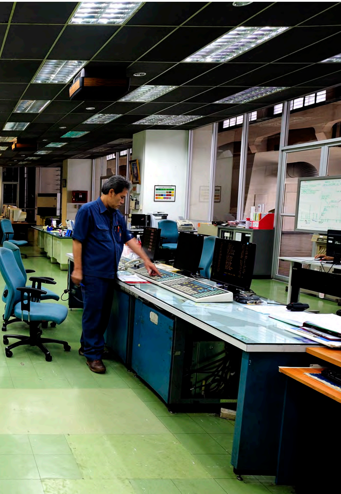
บรรยากาศการทำงานใน ห้องคอนโทรลรูมของ โรงไฟฟ้าเทอร์มอล ซึ่งกลายเป็นอดีตไปแล้ว
