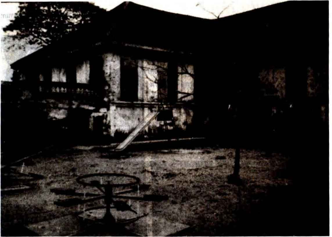
ด้านหลังเพนียดอาคารหลังหนึ่ง ของ โรงเรียนฝึกหัดครูกรรมเพนียด
