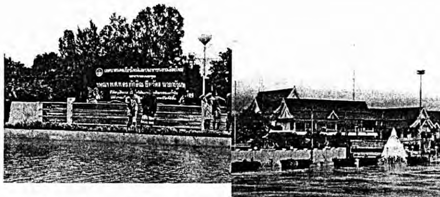
น้ำท่วมถนนบริเวณแม่น้ำปิงหน้าเทศบาลนครเชียงใหม่
