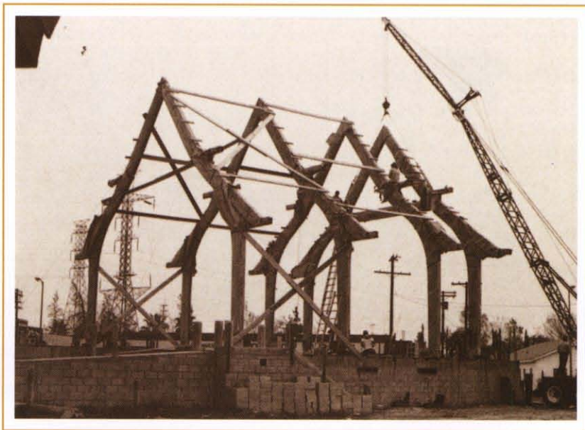
การก่อสร้างโครงอาคารอุโบสถศาลา
