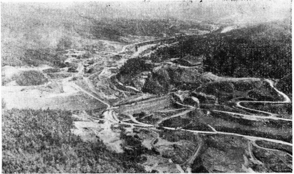
บ่อก่อสร้างเขื่อนสิริกิติ์ บนแม่น้ำน่าน จังหวัดอุตรดิตถ์ ซึ่งเห็นทำนบชั่วคราวทั้งสองด้าน
