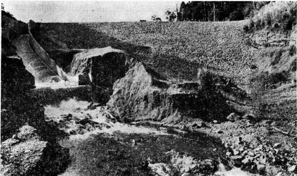
ทำนบของอ่างเก็บน้ำเขาระกำ จังหวัดตราด ถ่ายจากด้านท้ายน้ำ ทางซ้ายของภาพคือทางระบายน้ำล้น
