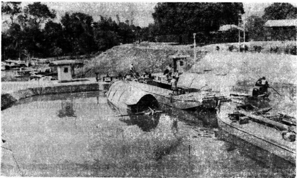
ประตูประนเรตร์ แสดงอ่าง หัวตอม่อด้านท้ายน้ำ และความแตกต่างของระดับน้ำทั้งสองด้าน
