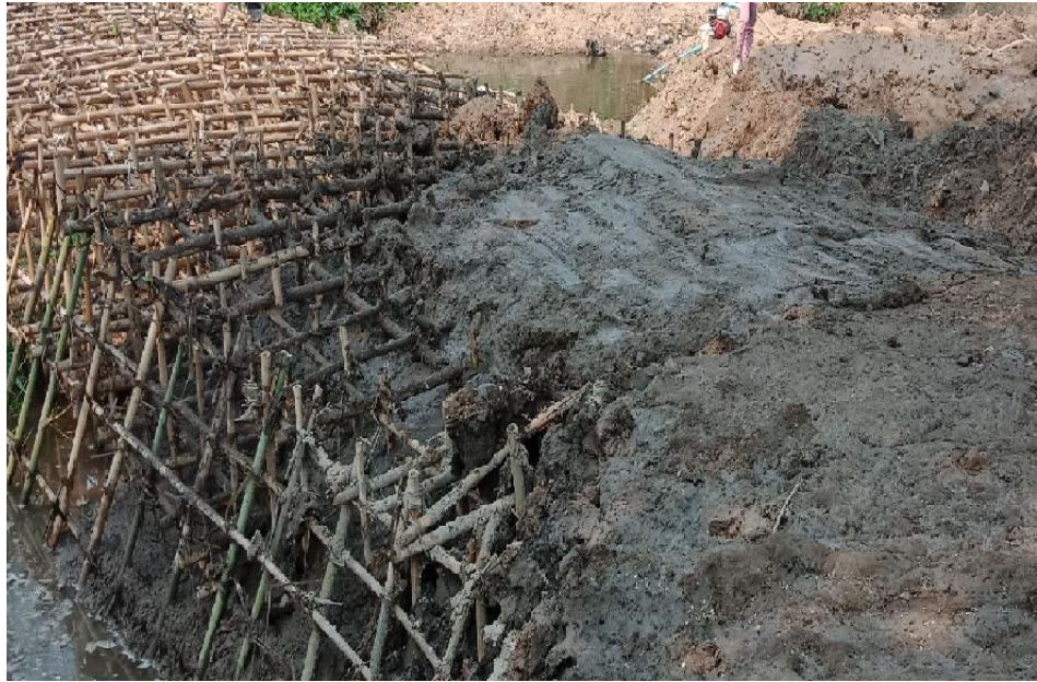
ภาพที่ ๑๐ ฝายชุมชนบ้านแม่ลาน ขณะกำลังก่อสร้าง
