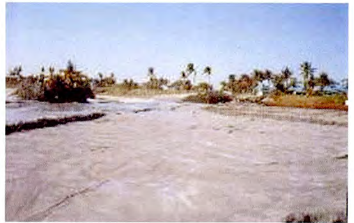
รูปที่ 3-17 การปรับระดับทรายหลังจากนำทรายมาพ่นลงบนชายหาด
