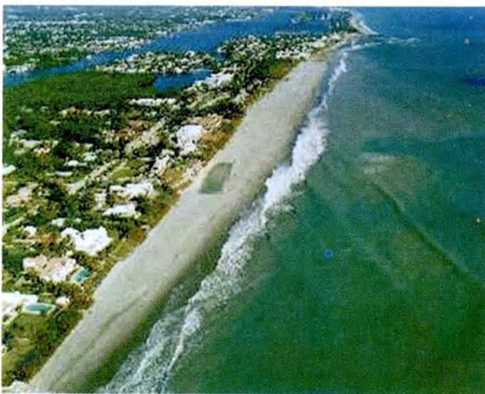
รูปที่ 3-18 ผลที่เกิดขึ้นจากการดำเนินการ ซึ่งได้สถานที่พักผ่อนที่ยังคงสภาพธรรมชาติ และเป็นแนวป้องกันความเสียหาย ที่จะเกิดต่อสิ่งปลูกสร้างจากพายุทำให้เกิดชายหาดกว้าง 200 ฟุต และยาว 1.42 ไมล์
