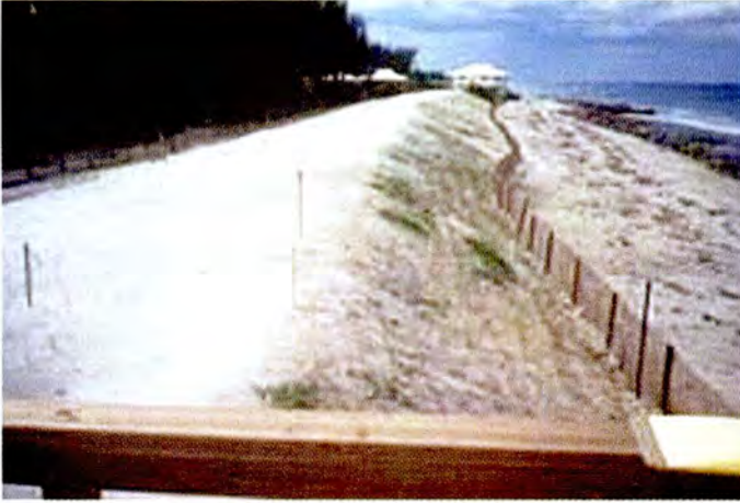
รูปที่ 3-10 ลักษณะของสันดอนทราย ที่เกิดขึ้นจาก การนำทรายถมและปรับความลาดเอียง
