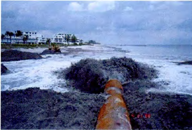
รูปที่ 3-16 ท่อขนาด 30 นิ้วที่ใช้พ่นทรายลงบนชายหาด ซึ่งมีประสิทธิภาพในการพ่นทราย 60,000 ลูกบาศก์หลา/วัน
