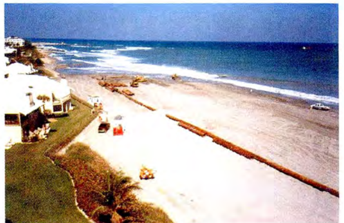
รูปที่ 3-15 ทรายจะถูกลำเลียงจากเรือดูดทรายไปยังชายหาด ด้วยท่อลอยน้ำและท่อใต้น้ำ
