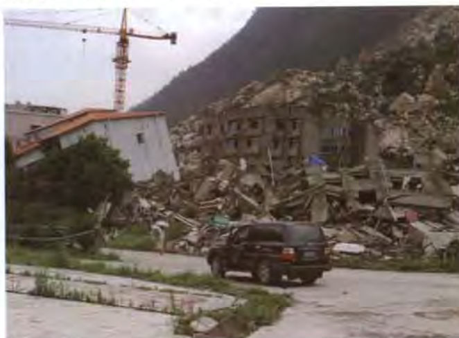
ภาพ ๒-๒๖ อาคารในเมืองเหวินฉวน เสียหายในโครงสร้างที่สำคัญ ประเทศสาธารณรัฐประชาชนจีน
